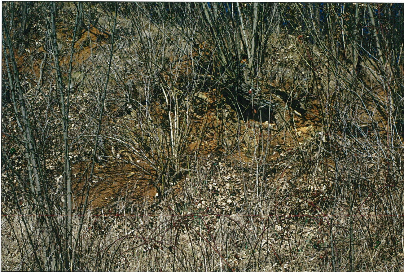
Foto – 3 Pohled na sklaní odkryv (vpravo) v silně zvětralé rule. Hornina ve svahu je značně rozvolněná kořeny náletového akátu. Km 1,515.
