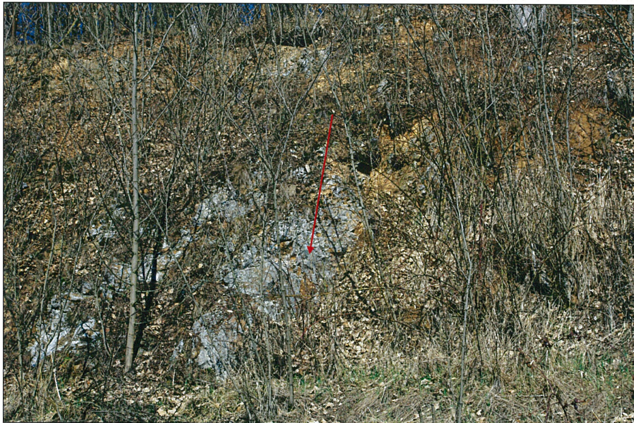
Foto – 4 Pohled na sklaní odkryv (vpravo) v silně zvětralé rule s polohou granitu (šedá plocha) viz šipka. Hornina ve svahu je značně rozvolněná kořeny náletového akátu. Km 1,520.
