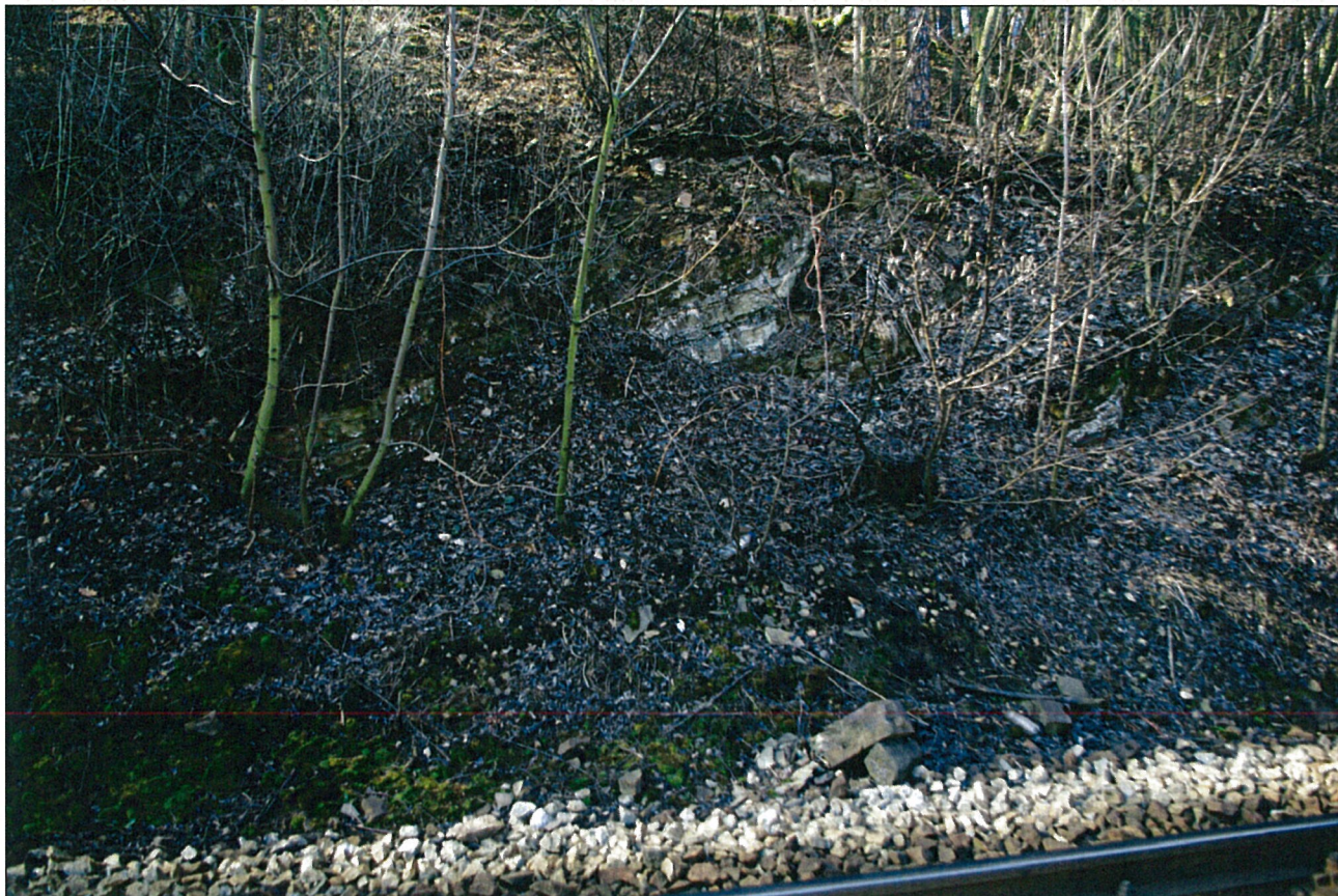
Foto – 7 Pohled na levý svah v km 8,680 s částečně odkrytými pískovci s polohami prachovců a jílovců.
